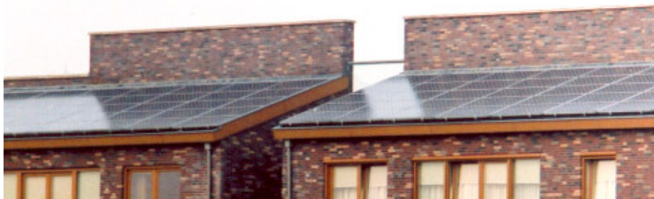
Zonnecellen op woningen aan de Kantelen in Boxtel
