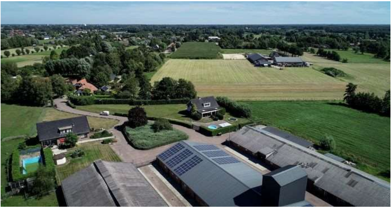
Lichtgewicht panelen van Solarge op een boerderijdak © Solarge
