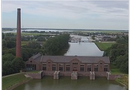
Ir. D.F. Woudagemaal met op de achtergrond het stroomkanaal
