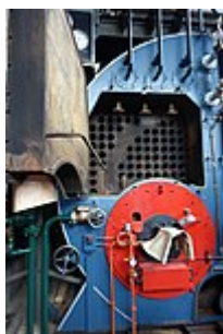
Detail ketel met de ronde rookkanalen
